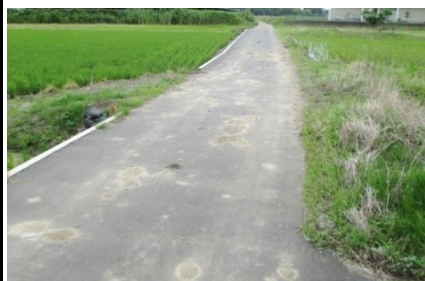
舗装整備箇所
