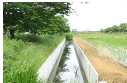
かんがい排水路整備箇所
