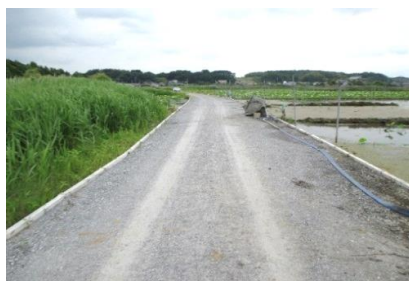
農道整備箇所
