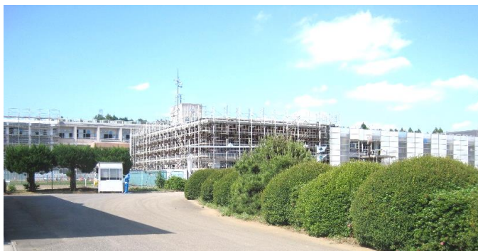
新治中学校 工事状況
