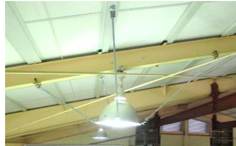
照明器具 落下防止取付後
