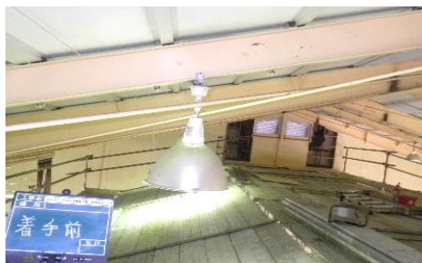
照明器具 落下防止取付前
