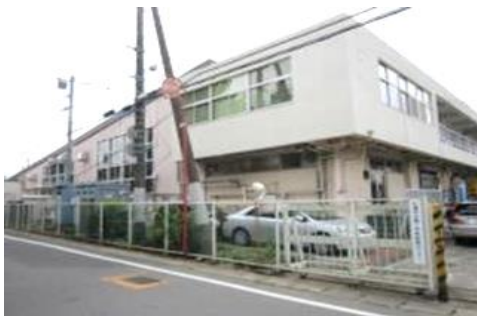
第1学校給食センター (築46年)
