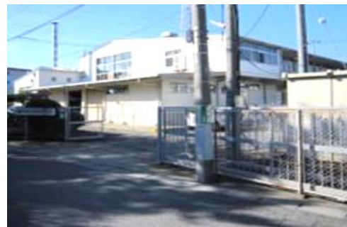
第2学校給食センター (築41年)
