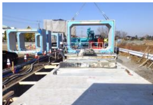
神立菅谷雨水幹線 ボックスカルバート布設状況
