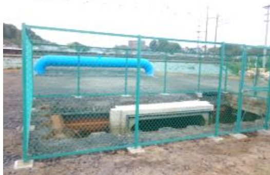
木田余1号雨水幹線 J R 常磐線横断部整備状況
