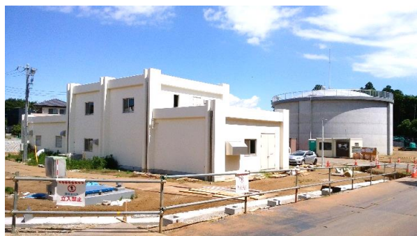
配水ポンプ室・配水池
