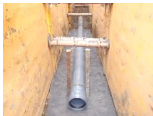
汚水管渠布設状況
