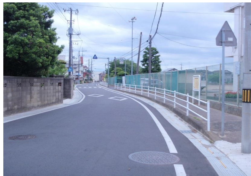
市道Ⅰ級38号線（荒川沖東三丁目）整備状況
