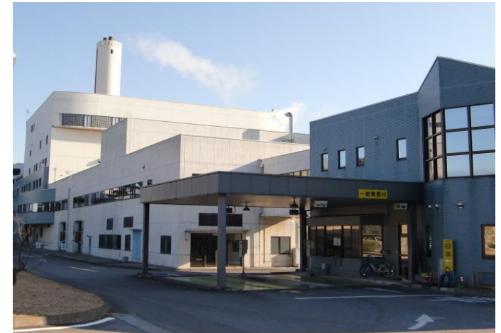
清掃センター外観
