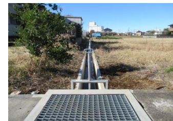
排水路整備工（完成）
