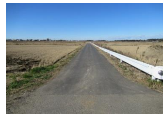
農道舗装工（完成）
