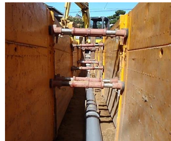
右舳第一処理分区整備状況
