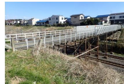
常磐線3号橋（二番橋）現況
