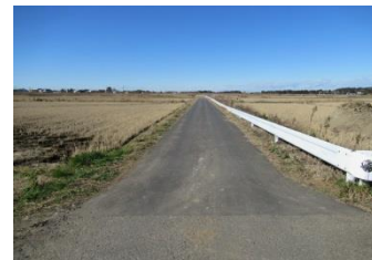
農道舗装工（完成）
