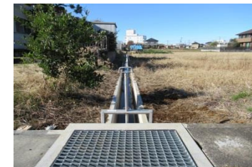
排水路整備工（完成）
