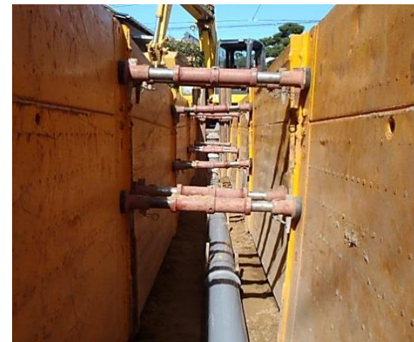
右舳第一処理分区整備状況
