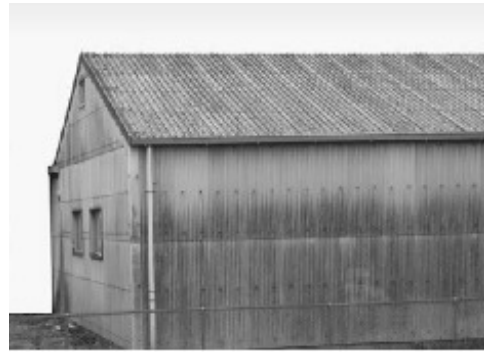
石綿含有スレート波板（屋根・外壁）
