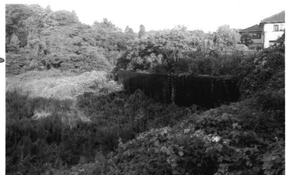
小坂団地 第2沈殿槽(第1児童公園下) 撮影H20-9-12
