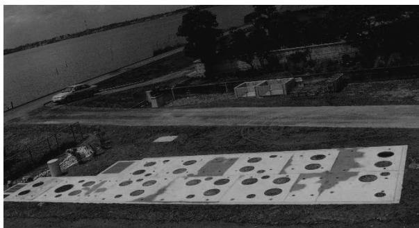
図6 沖宿町生活排水路浄化施設外観（竣工時）
