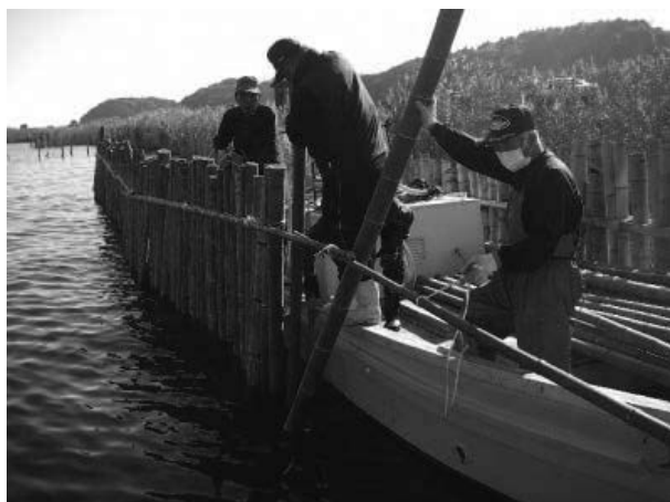
〔写真4：水生植物帯保護柵の設置〕
