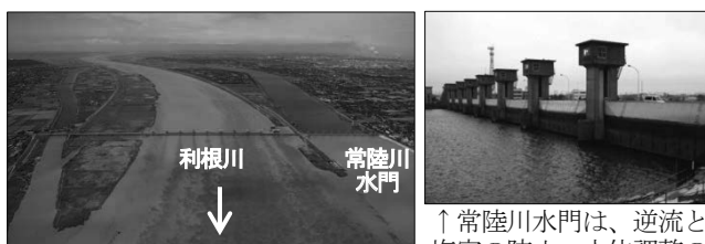
↑「平成27年9月関東・東北豪雨」利根川からの逆流防止の様子 ↑常陸川水門は、逆流と塩害の防止、水位調整の3つの大きな役割を持つ
