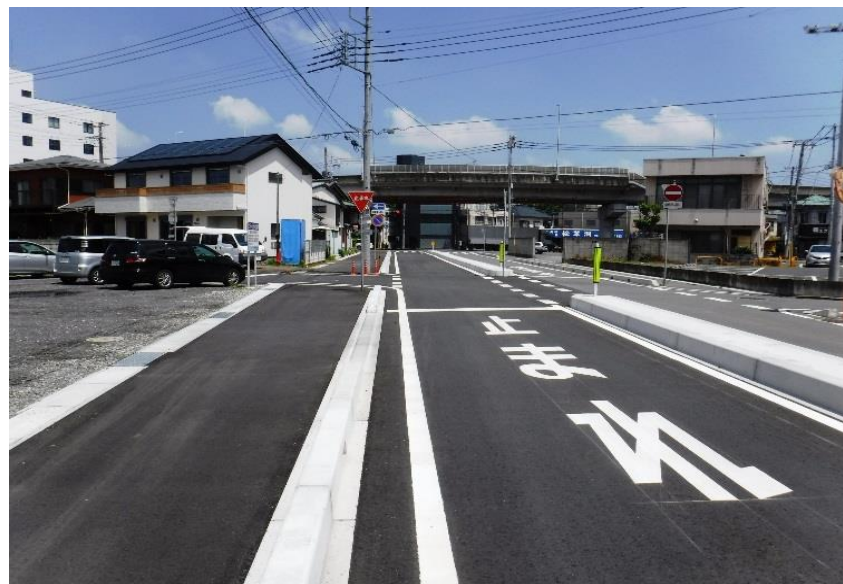
市道桜町四丁目6号線 整備状況
