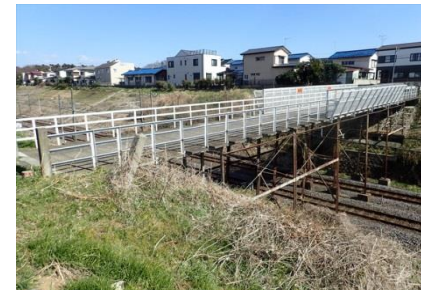
常磐線3号橋（二番橋）現況
