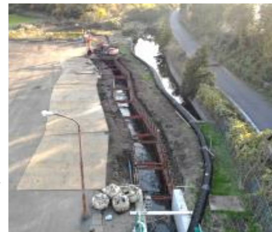
西根竹の入都市下水路整備状況
