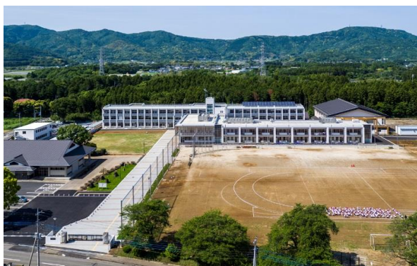
工事完成後 全景
