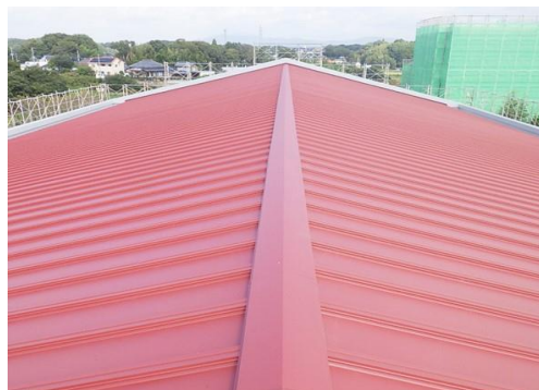
屋内運動場屋根 工事完成後
