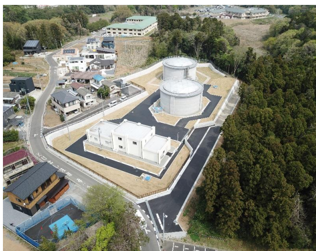
右廻配水場上空撮影写真
