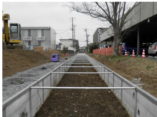
神立菅谷雨水幹線 排水路整備状況(JR常磐線西側)
