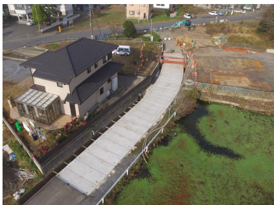
神立菅谷雨水幹線 排水路整備状況(JR常磐線東側)
