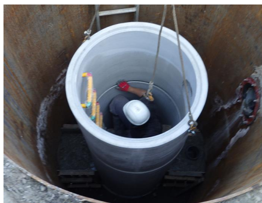
組立1号マンホール設置状況
