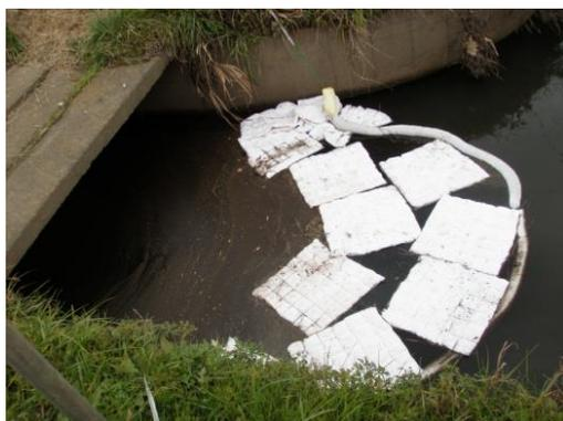
河川への油流出により吸着シートを使った対応
