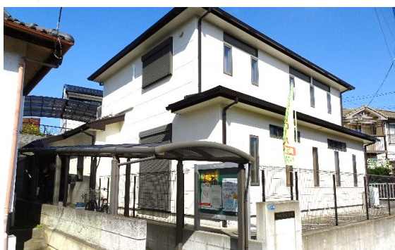
名 称：中村東町公民館 修繕内容：外壁・屋根塗装, 照明器具交換 他
