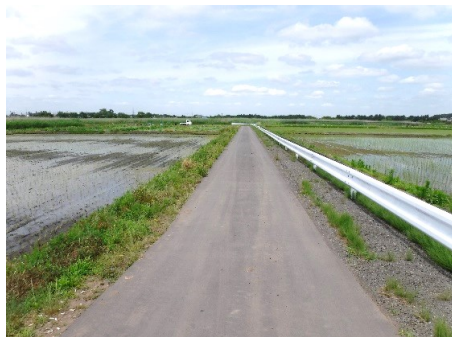
農道舗装箇所
