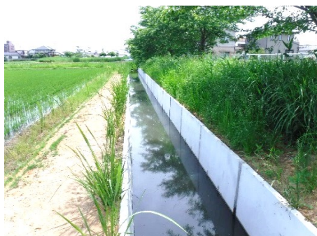
かんがい排水路整備箇所
