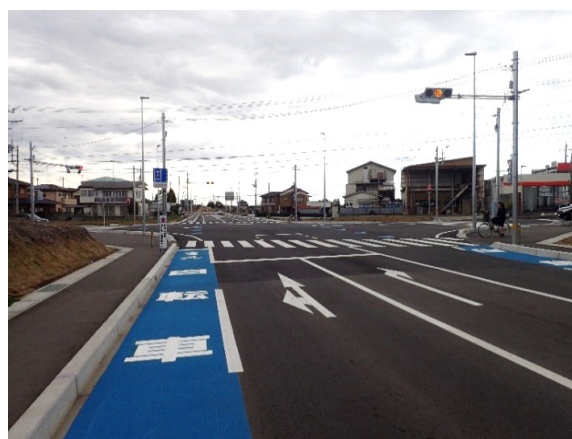
整備状況写真
