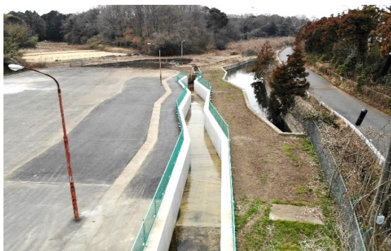
西根竹の入都市下水路 施工後
