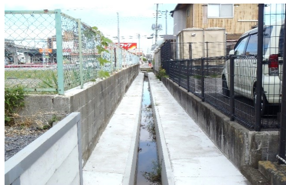
田中三丁目地内小規模排水路 施工後
