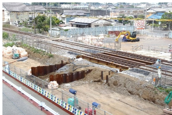
神立菅谷雨水幹線 排水路整備状況(JR常磐線横断部)
