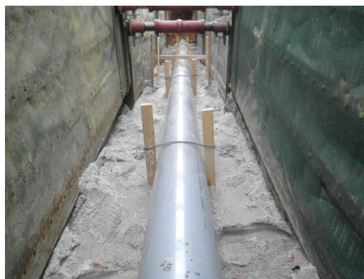
汚水管渠布設状況
