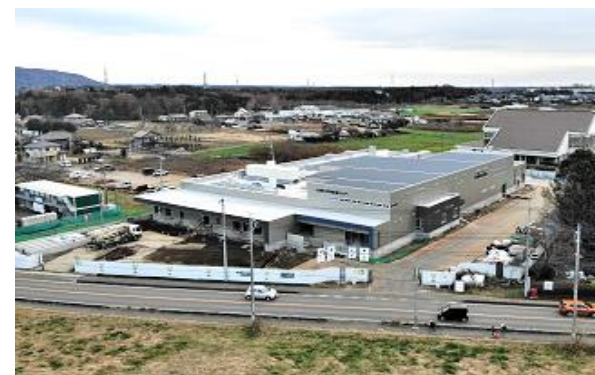
令和元年12月現在の整備状況
