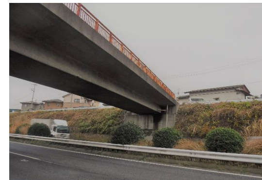
国道六号9号橋 現況
