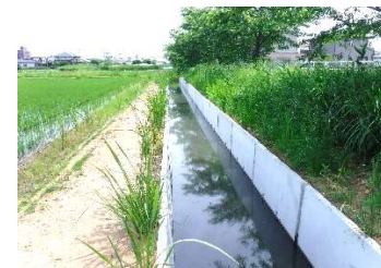
排水路整備工(完成)
