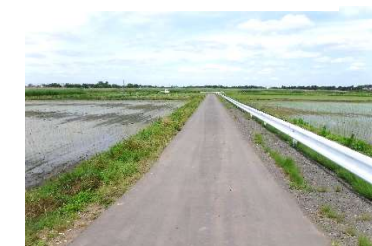
農道舗装工(完成)
