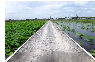
農道改良工(完成)
