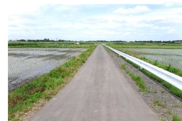
農道舗装工(完成)
