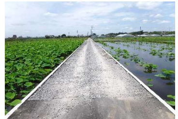
農道改良工(完成)
