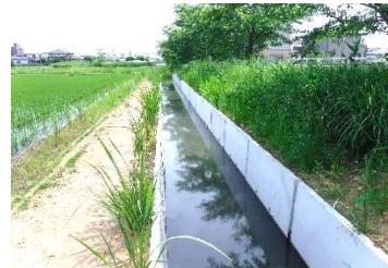
排水路整備工(完成)
