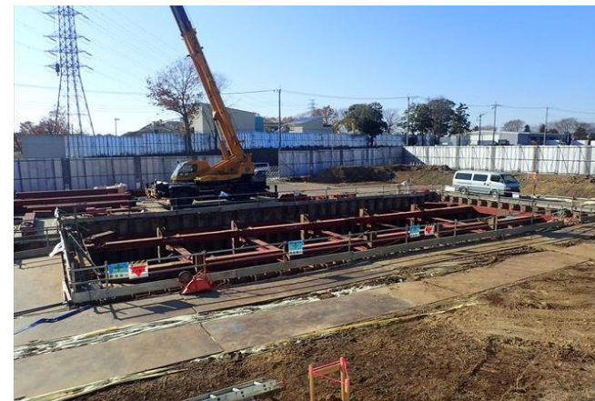
東筑波新治工業団地ポンプ場整備状況
