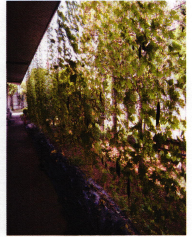
内側からの写真 グリーンカーテン設置状況
