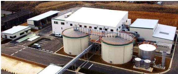
メタン発酵・堆肥化施設 日立セメント(株)
