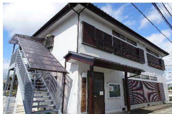
名 称：中村南児童館 修繕内容：板金、木製建具、屋根、外壁塗装、 サッシ
