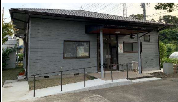
名 称：藤沢団地集会所 修繕内容：基礎工事、玄関、ホール、洋間、 トイレ、厨房、物入、玄関ポーチ 等
