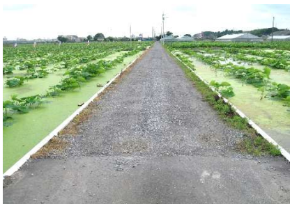
農道整備箇所
