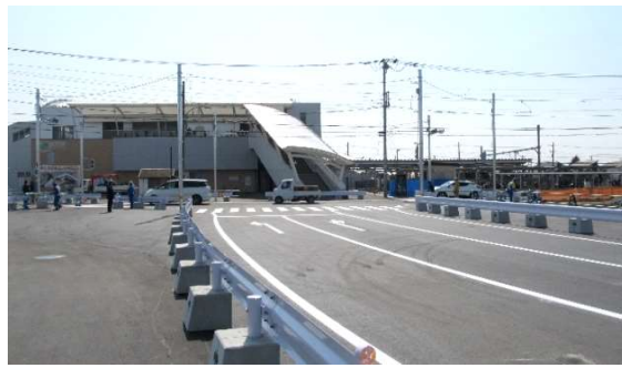
神立停車場線整備状況（神立駅方面）
