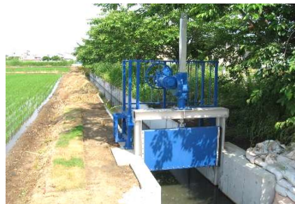
かんがい排水路整備箇所
