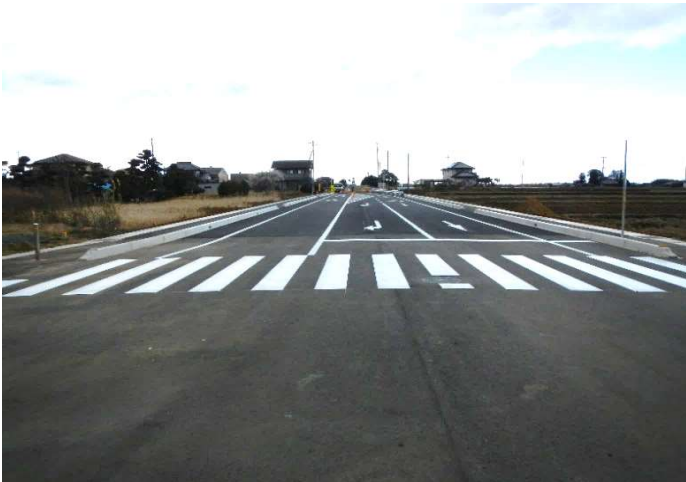
整備状況写真
