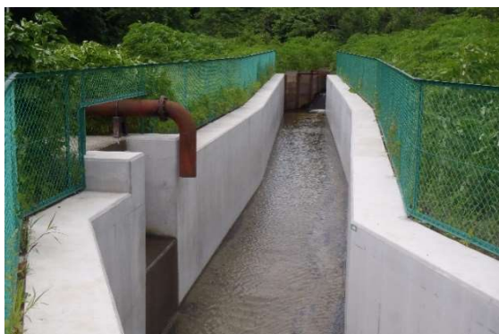
西根竹の入都市下水路 施工後
