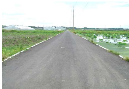
農道舗装箇所
