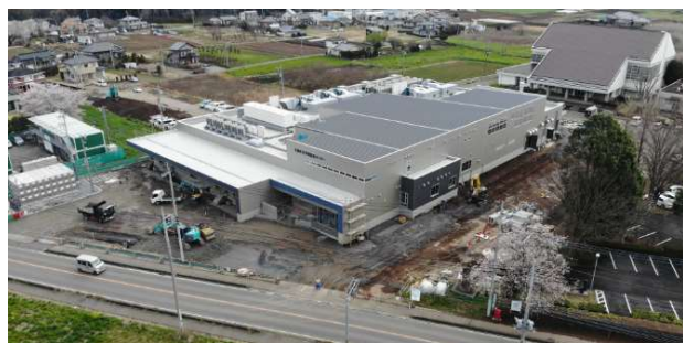
令和2年3月の工事状況
