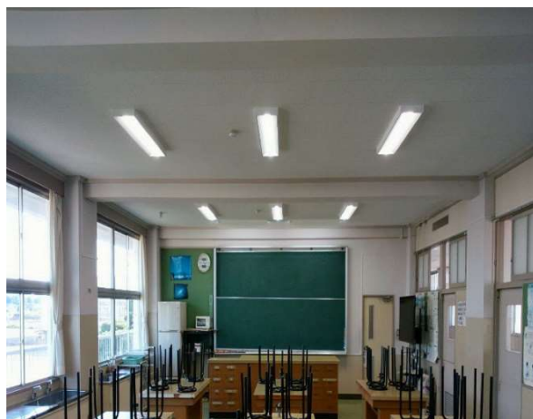
理科室照明 工事完成後
