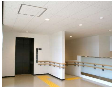
エレベーター及びスロープの設置
