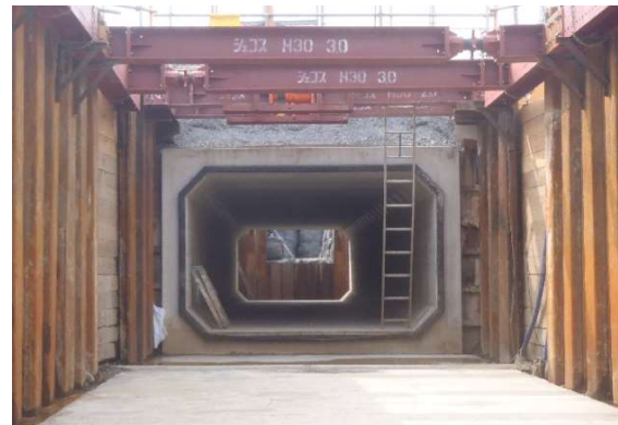
神立菅谷雨水幹線 排水路整備状況（J R 常磐線横断部）
