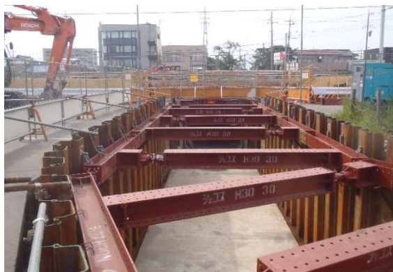
神立菅谷雨水幹線 排水路整備状況（J R 常磐線東側）
