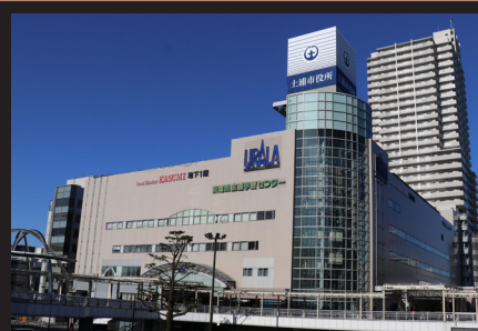
平成27年に土浦駅前に移転した、現在 の市役所本庁舎(写真は令和2年)
