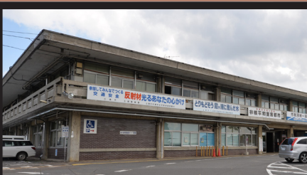
昭和38から平成27年まで使用されて いた市役所本庁舎(写真は平成27年)
