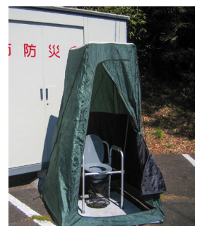
マンホールトイレ
