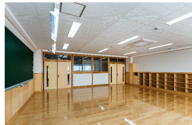
平成27年度 改築工事実施 都和小学校 普通教室ＬＥＤ照明
