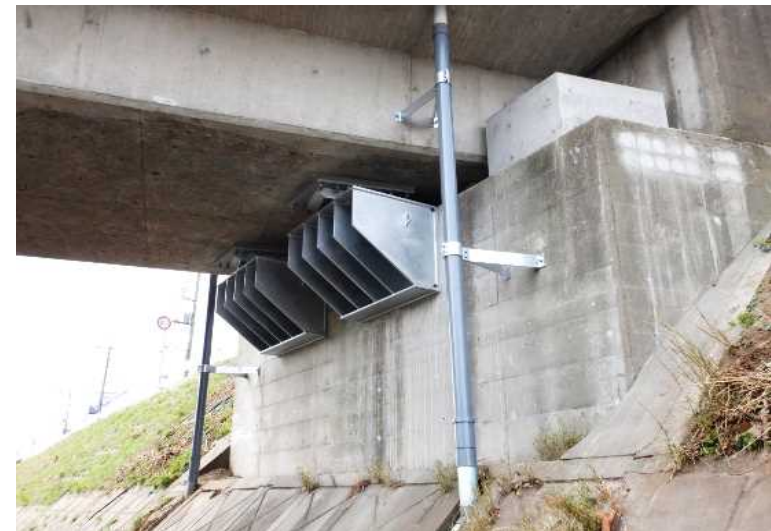
国道六号8号橋 落橋防止施工後
