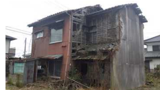
解体撤去工事を行う特定空家等
