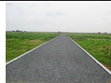
農道改良工（完成）
