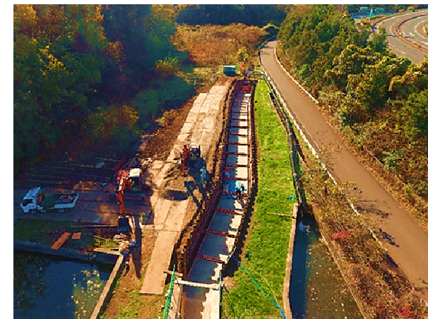
西根竹の入都市下水路整備状況
