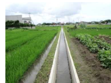
排水路整備工（完成）
