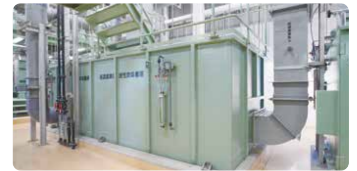
活性炭吸着塔
