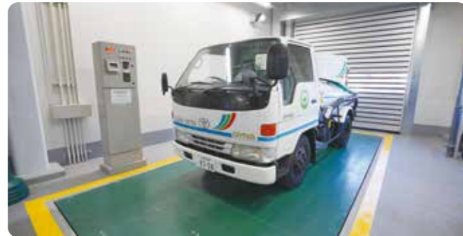
トラックスケール
