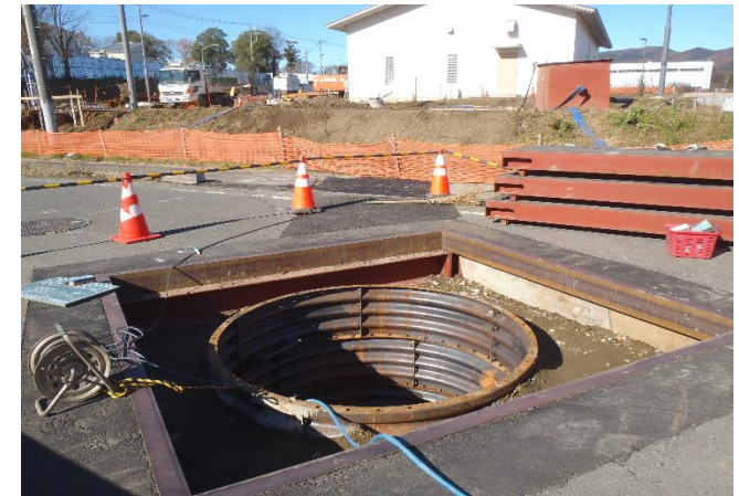
東筑波新治工業団地ポンプ場整備状況 (既設管切替工事)
