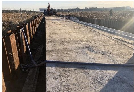
木田余1号雨水幹線整備状況
