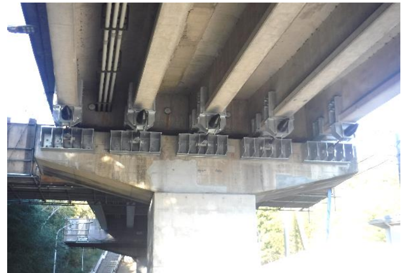
東真鍋1号橋(木田余立体橋)落橋防止施工後
