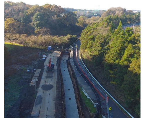
西根竹の入都市下水路整備状況
