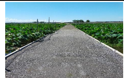
農道改良工（完成）
