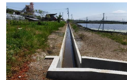
排水路整備工（完成）
