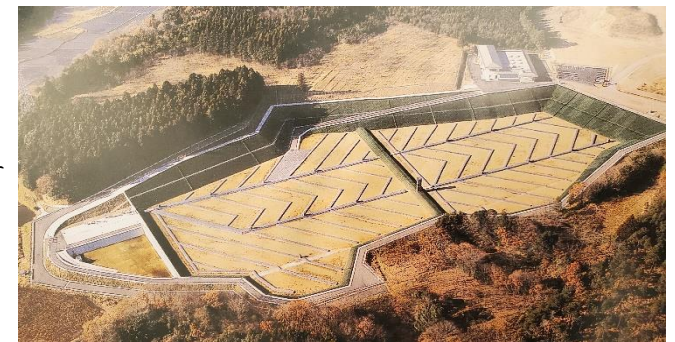
一般廃棄物最終処分場
