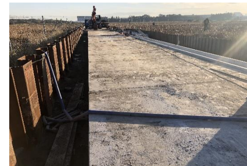
木田余1号雨水幹線整備状況
