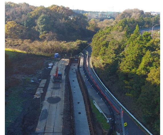
西根竹の入都市下水路整備状況
