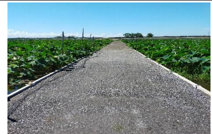
農道改良工（完成）
