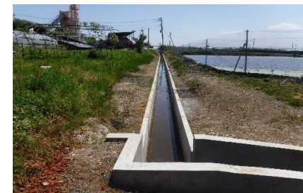
排水路整備工（完成）
