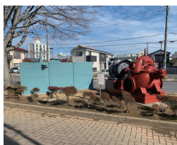
旧川口川閘門鉄扉及び排水ポンプ (川口一丁目)
