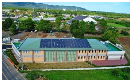
■太陽光発電システム
