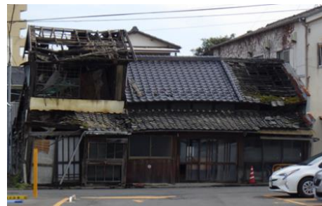
■ 管理不全な空き家
