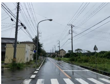
①前面道路（東方向）
