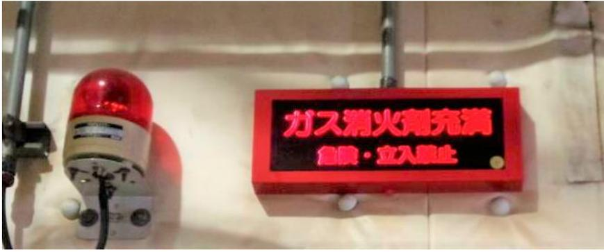
不活性ガス消火設備（二酸化炭素消火設備）が設置されている出入口付近には、**放出表示灯**が設置されています。付近で作業等を行う際には、十分気をつけて下さい。
