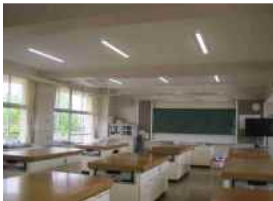
乙戸小学校 LED照明器具
