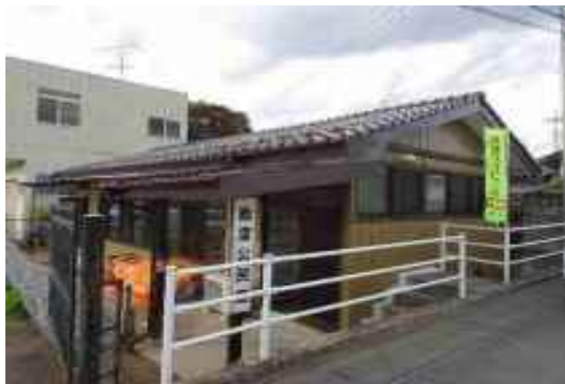
名称：殿里公民館 修繕内容：木製建具を金属サッシへの変更、床のフローリング化、玄関の段差解消 等
