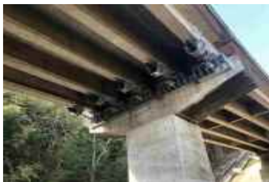
東真鍋1号橋(木田余立体橋)
