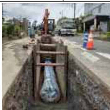
送水管布設替工事の様子
