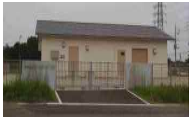
東筑波新治工業団地ポンプ場 施工後 （土木工事）
