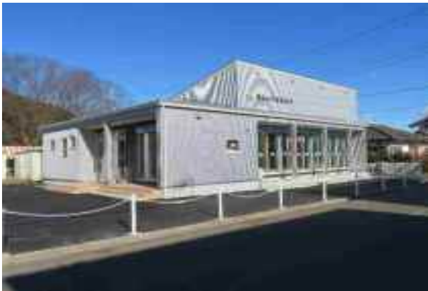
名称：烏山二丁目集会所 構造：木造ガルバリウム鋼板葺平屋建
