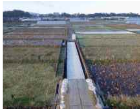
木田余1号雨水幹線 排水路整備状況(JR常磐線東側)
