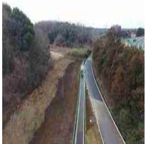
西根竹の入都市下水路 施工後
