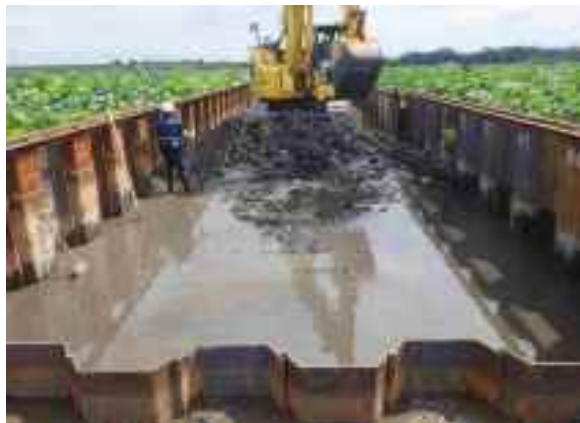
木田余1号雨水幹線 排水路整備状況(JR常磐線東側)
