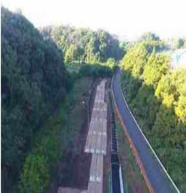
西根竹の入都市下水路 施工前
