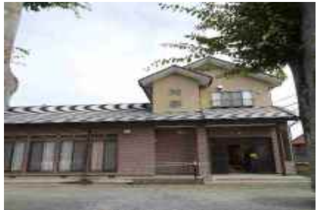
名称：並木町児童公民館 修繕内容：LED更新、エアコン修繕、クロス張替、ビルトインコンロ取換
