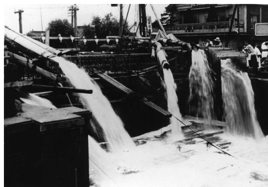
写真3 ポンプでの排水(昭和16年)
