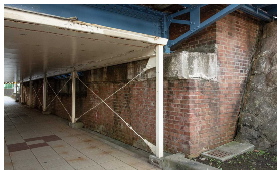
写真1 線路下の赤煉瓦造りの護岸跡(現在)
