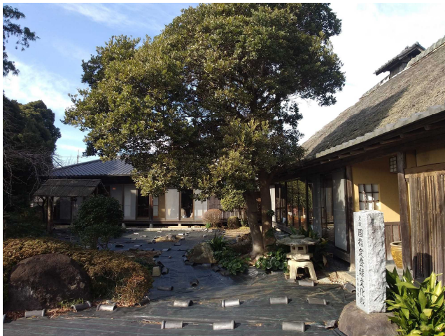
一色家住宅主屋(右)と敷地内の建物(左手奥)
