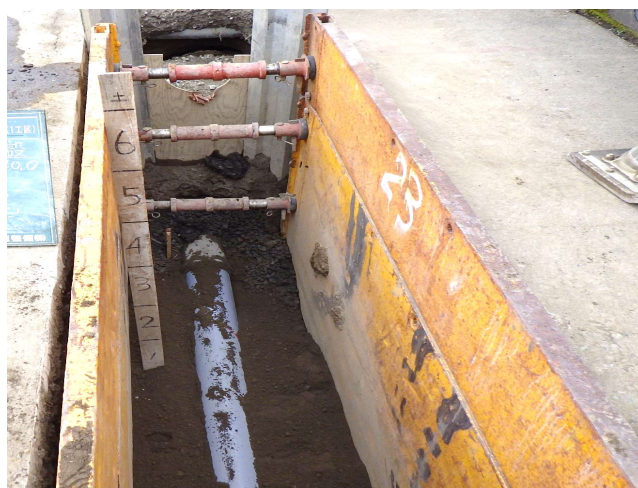
手野町地内 汚水管渠整備状況
