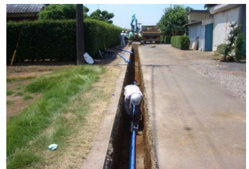
中都町二丁目地内配水管布設工事
