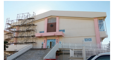
令和4年度の神立小学校体育館 長寿命化改良工事のようす
