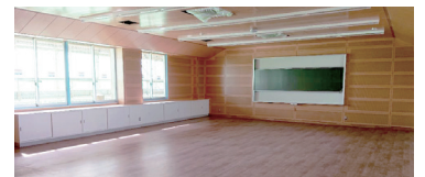
土浦四中 改修中の教室
