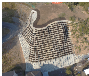
急傾斜地崩壊対策工事
