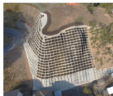
急傾斜地崩壊対策工事
