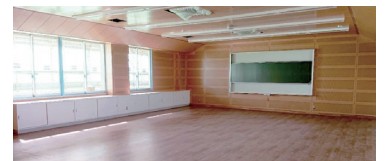
土浦四中 改修中の教室
