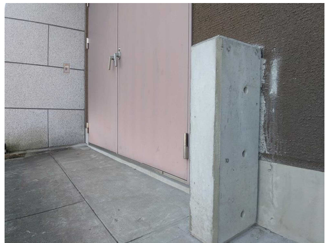
止水板の基礎工事
