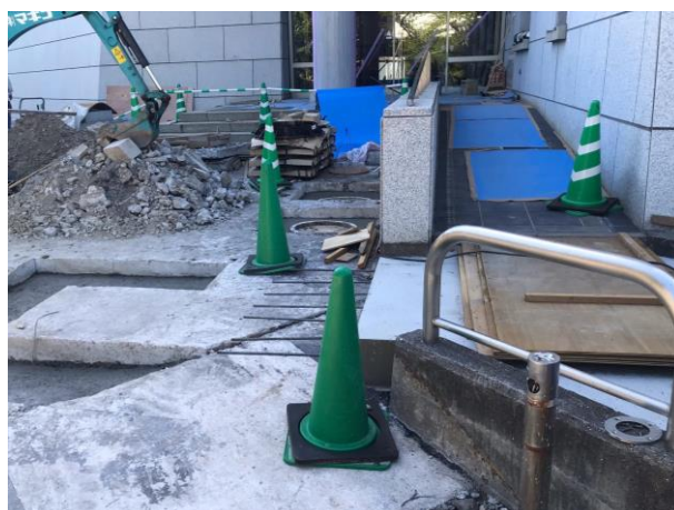
スロープや舗装の改修
