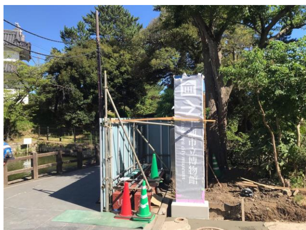
新設した入口の看板
