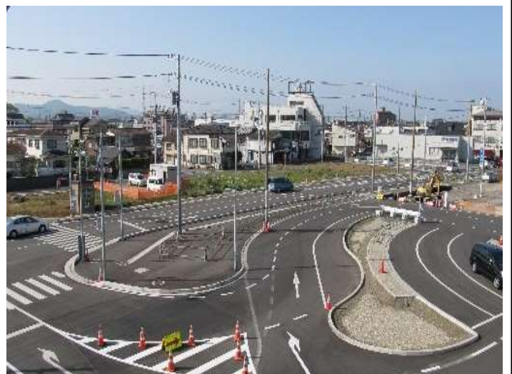
神立駅西口駅前広場周辺整備状況
