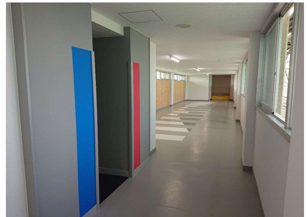
土浦第四中学校校舎棟長寿命化改良工事 内装
