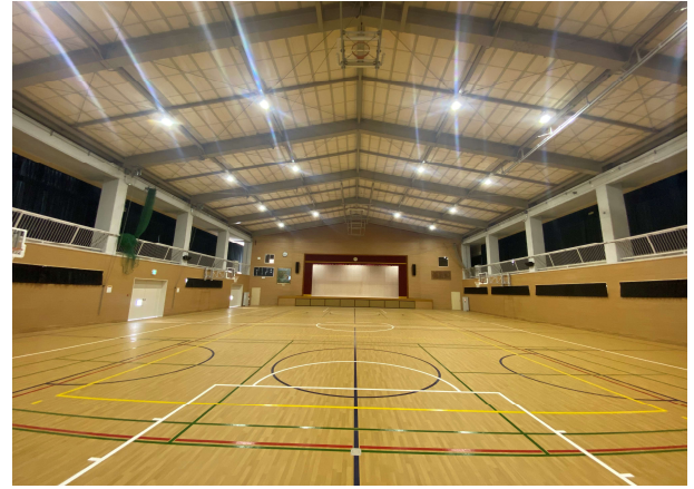
神立小学校屋内運動場及び特別教室棟 長寿命化改良工事アリーナ
