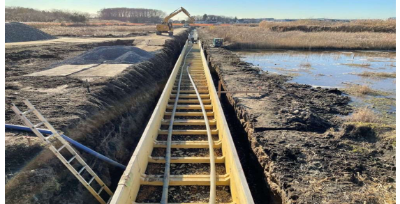
神立菅谷雨水幹線 （調整池）整備状況
