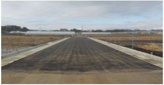
木田余1号雨水幹線 排水路整備状況（JR常磐線東側）
