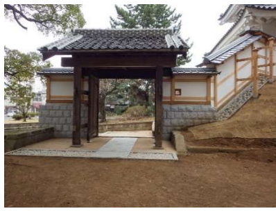
本丸側から見た改修工事後の霞門
