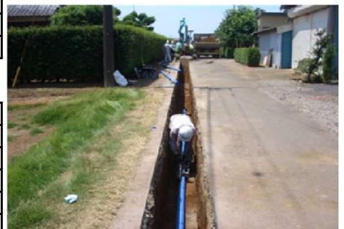
配水管布設工事の様子
