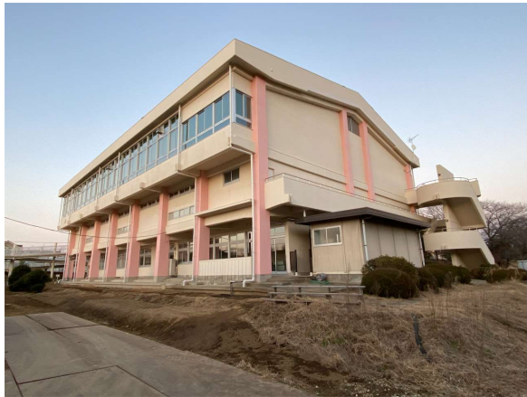
神立小学校屋内運動場及び特別教室棟 長寿命化改良工事外観
