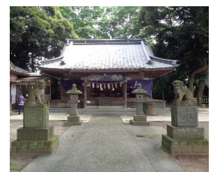
建造物：八坂神社拝殿
