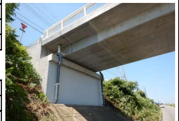
国道六号7号橋 (耐震対策実施)
