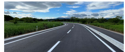
市道虫掛66号線整備状況
