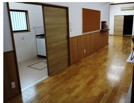
田中一丁目児童公民館 (トイレの移設・内装の張替え・ 床のフローリング化)
