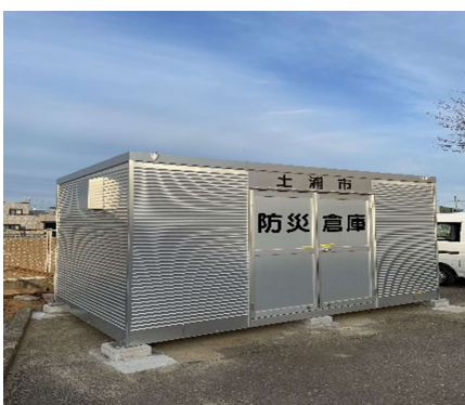
防災倉庫の整備
