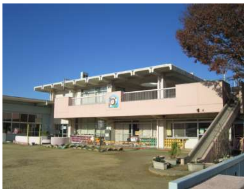
移管前の新生保育所の園舎
