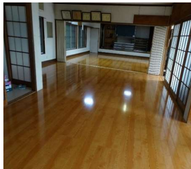
小山田町公民館修繕 (畳床のフローリング化)
