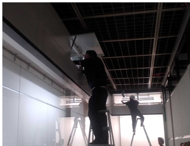
LED照明交換作業
