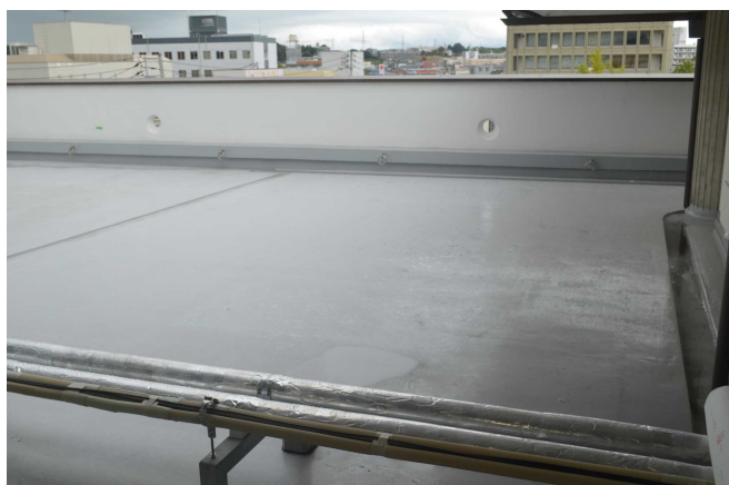
屋上防水処理施工後
