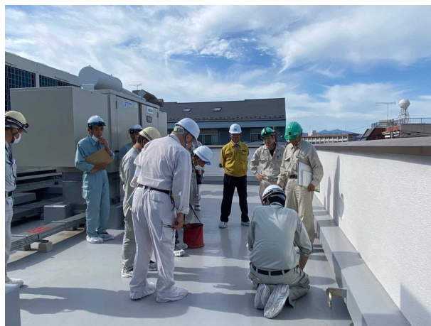
工事検査のようす(屋上)
