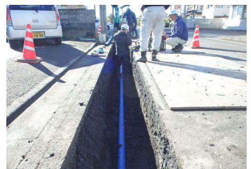
港町一丁目地内外配水管布設工事
