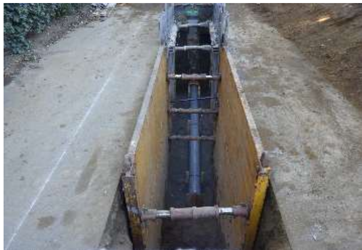
沖宿町地内 汚水管渠整備状況
