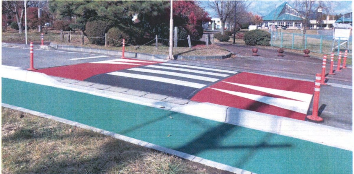
スムーズ横断歩道設置状況
