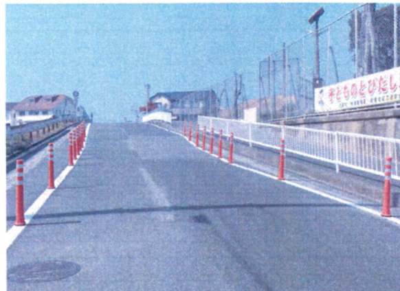
中央線の消去・狭く設置状況(福岡県古賀市)
